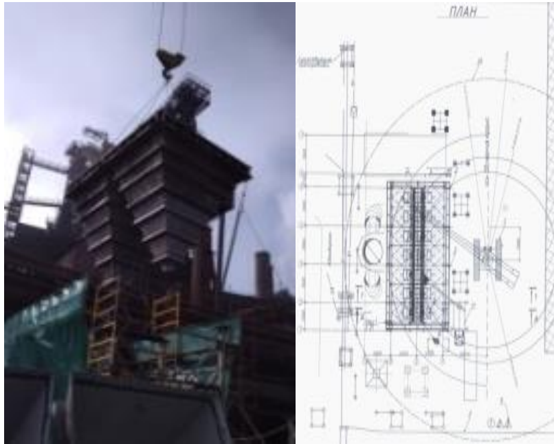
Рис. 2. Монтаж м/к блоков опорного пояса с бункерами
